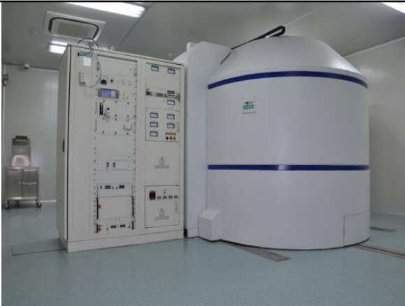
回旋加速器机房
